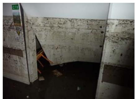
津波の水圧でCT室の引き戸は変形
